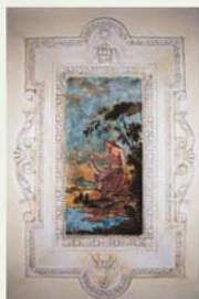
Dipinti murali a soffitto. Dopo il restauro
