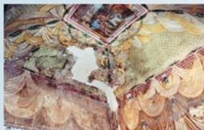
Prima del restauro
