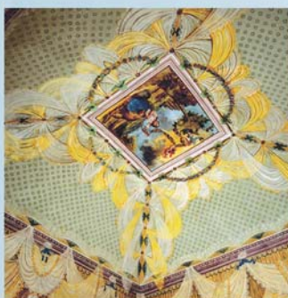
Soffitti interamente decorati. Dopo il restauro
