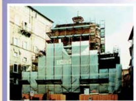
La Chiesa durante le fasi di restauro
