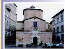
La Chiesa dopo gli interventi di restauro
