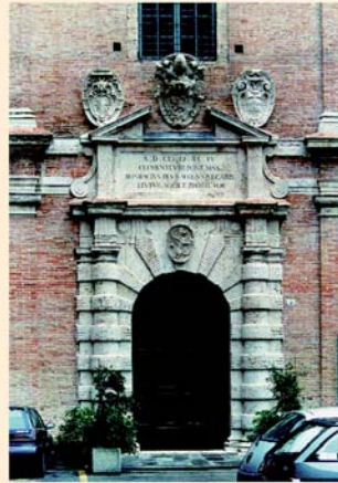
portale della Chiesa dopo il restauro
