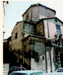
la Chiesa prima del restauro
