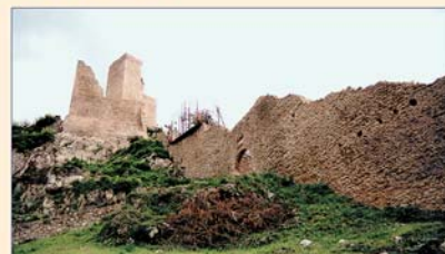
Torre e cinta muraria dopo i restauri
