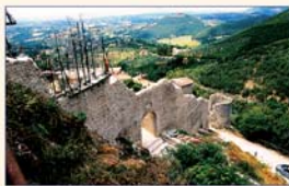
Cinta muraria dopo i restauri
