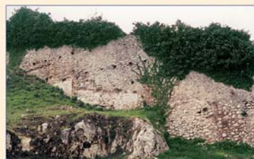
Particolare della cinta muraria prima del recupero
