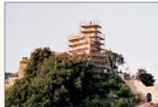
Durante i lavori di restauro
