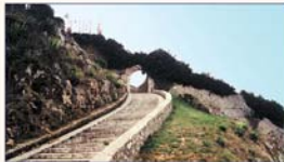
Cinta muraria prima dei restauri
