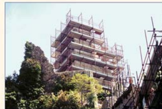
Durante i lavori di restauro
